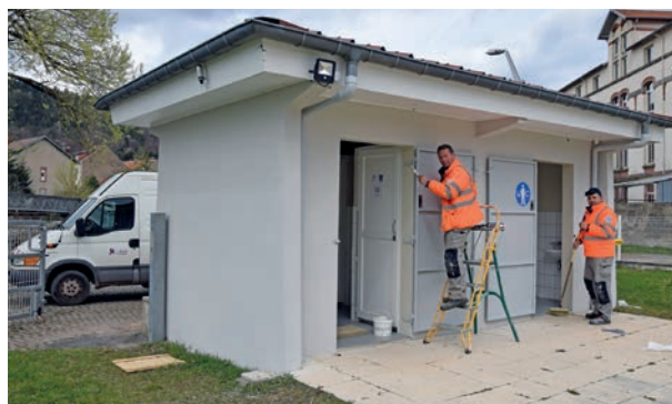
D'importants travaux de peinture ont été réalisés par les Services Techniques à la piscine municipale (ici Éric Marchal et Hakan Uysal).
