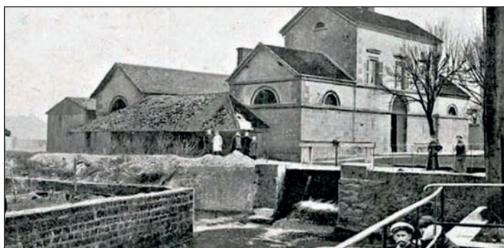
L'abattoir vu du quartier de l'île. À l'étage, le logement du gardien.
