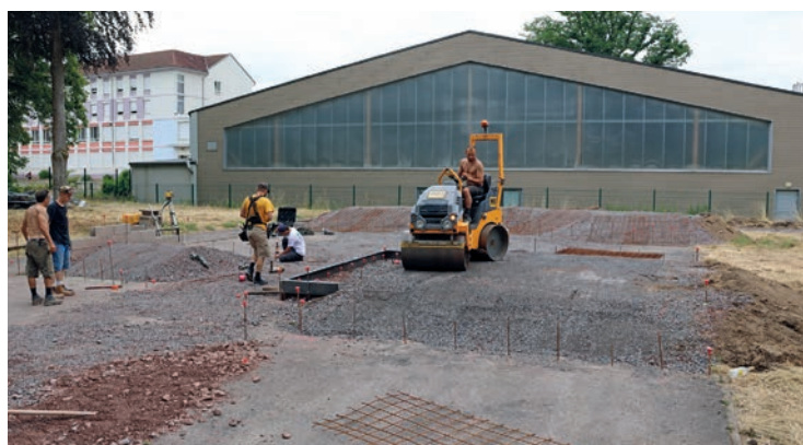
Les travaux ont démarré sur le site du futur pump track. Actuellement, c'est le skate park qui sort de terre.
