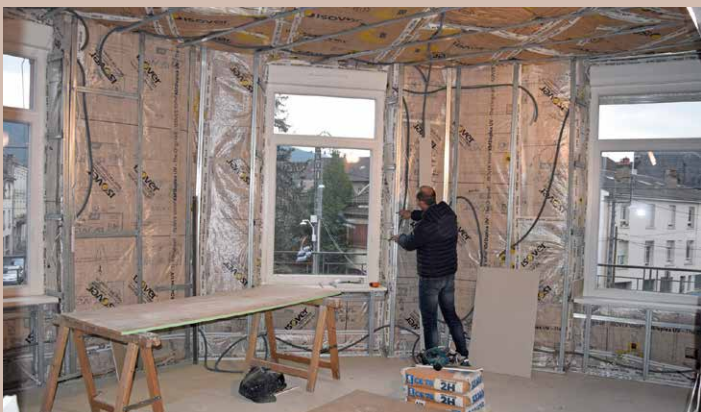
Poursuite du chantier de rénovation du logement 1, rue JB Demenge.
