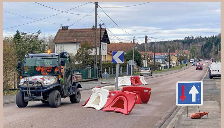
Pose de trois éclouses provisoires avenue De Gaulle pour limiter la vitesse.
