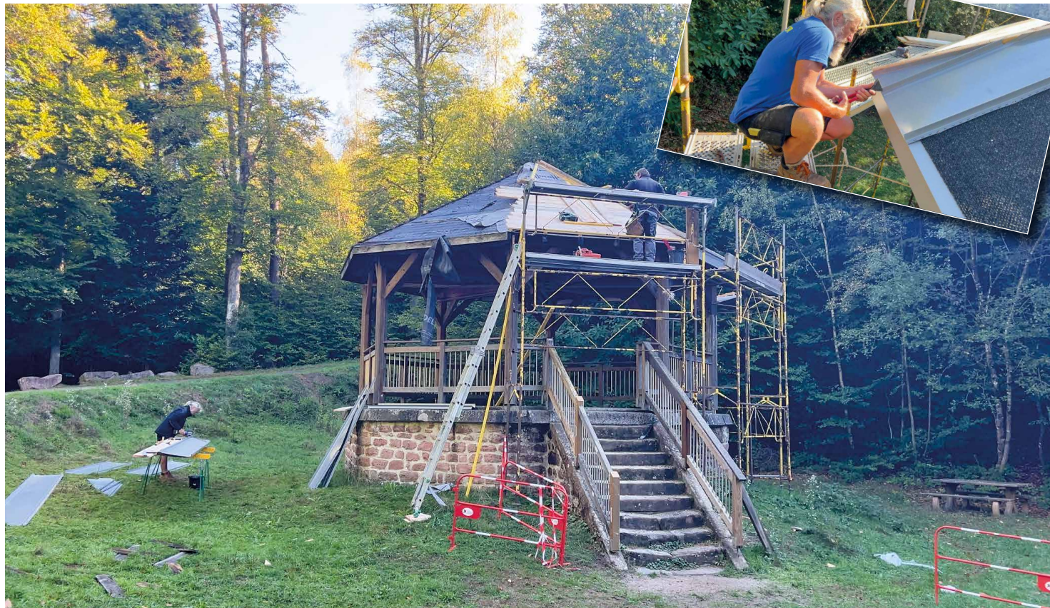
Tout au long du mois d'octobre, les couvreurs de la S.à.R.L. "Schœnher Christian" (Raon l'Étape) ont rénové la toiture du kiosque de la Criquelette.
