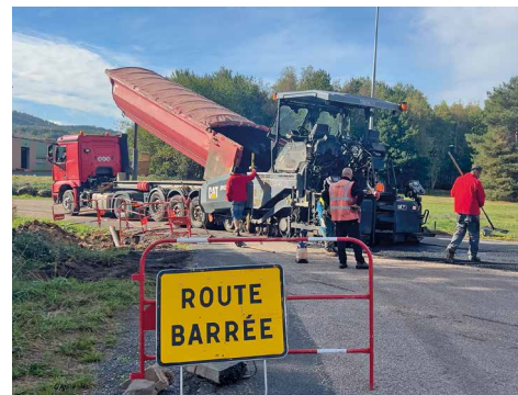
Mi-octobre, l'entreprise Lingenheld (Dabo - 57) a réalisé des travaux de réfection de voirie au carrefour rue de la Belle Orge / rue du Duc Ferry III, à proximité du passage à niveau.
