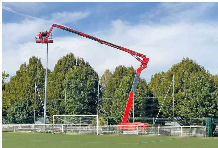
Fin septembre, à l'aide d'une nacelle qui monte à près de 30 m, Cédric Kuhn et Emmanuel Rupprecht des Services Techniques ont remplacé les lampes autour du stade du Sacré Cœur.
